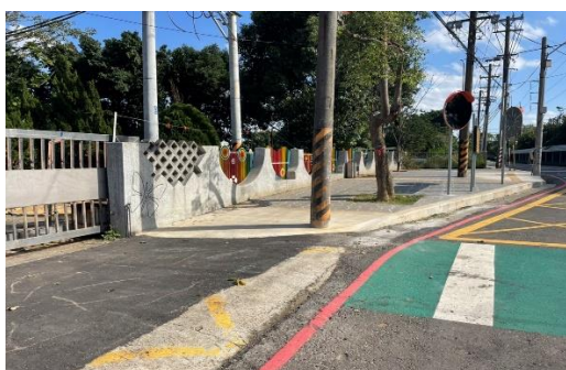
工業區服務中心增設人行道
