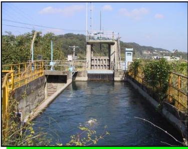
桂山發電軟電廠蓄水池
