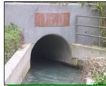
十二號隧道 (出)
