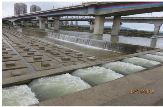
竹中橋下的水梯與石階
