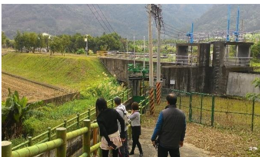
寶二水庫引水隧道
