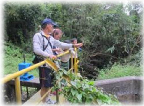
12 號隧道出水口
