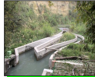
十二號隧道出口-水橋
