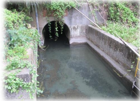
13 號隧道進水口
