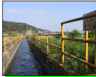
圳水流向一號隧道口
