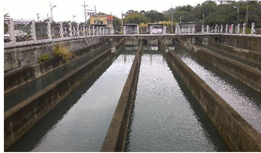
上坪堰進水口沉砂池
