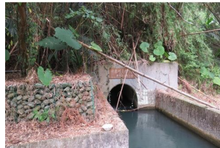
竹東圳第 13 隧道入
