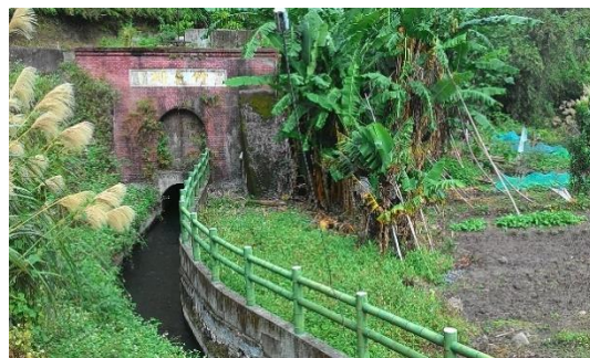
竹東圳一號引水隧道
