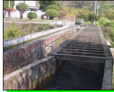
六號隧道入口前水橋
