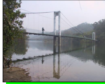
寶山水庫吊橋
