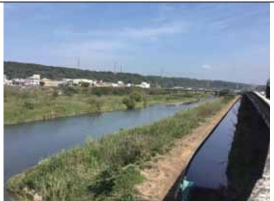
人工興建的灌溉圳溝
