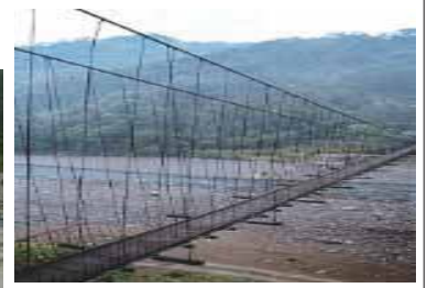
上坪溪南昌大橋
