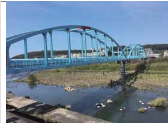
自來水輸送管橋
