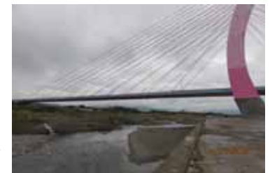
當年洪水氾濫斷橋舊跡
