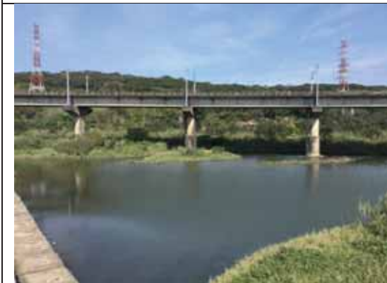
跨越鳳山溪的鐵道
