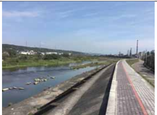
水泥堤防與被沖散的消波塊
