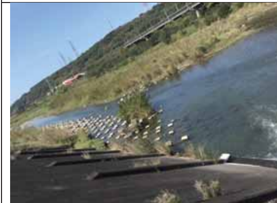
鳳山溪中散布的消波塊與水泥堤防
