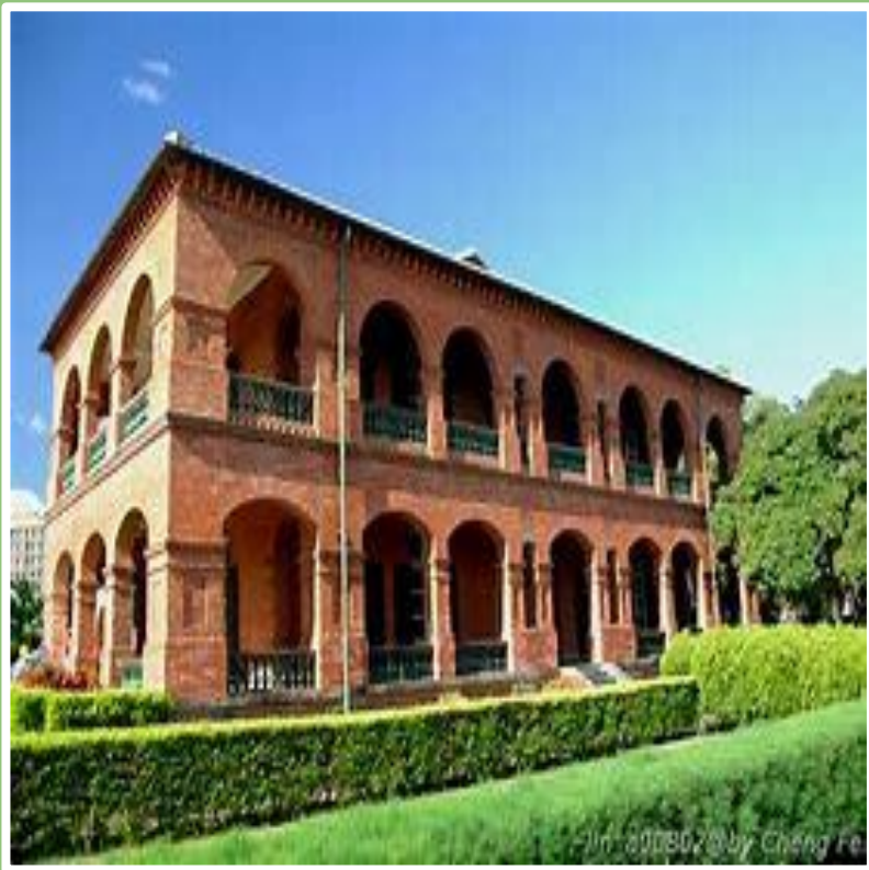
官邸一樓使用弧形拱，二樓則使用半圓拱。
