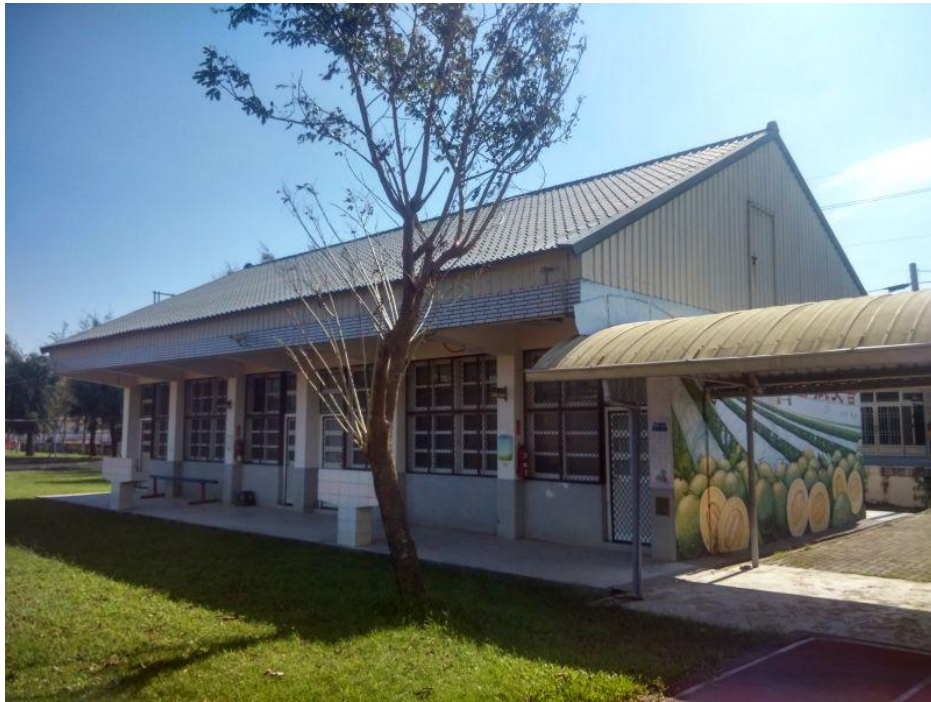
專科教室增建琉璃鋼瓦屋頂，前方並種植印度紫檀和草皮以降低室內溫度
