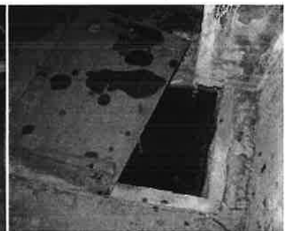
地下室污水池
