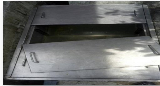
截油槽改善排放汙水
