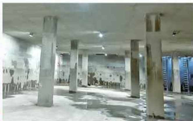
▲「正義國小透水保水工程」地下貯水槽 結構體完成
