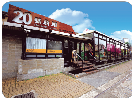
2 從臺灣鐵路局倉庫改為陳列藝術品的 臺中車站20號倉庫 。
