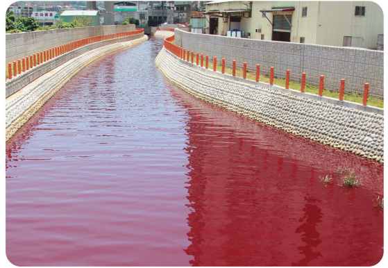
▲ 工廠亂排放廢水汙染水源
