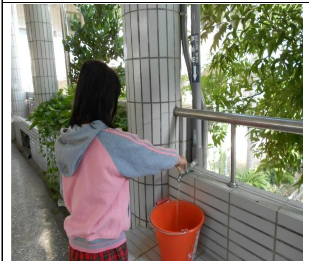
班級教室外有雨水專用水管供教室花圃澆灌用。
