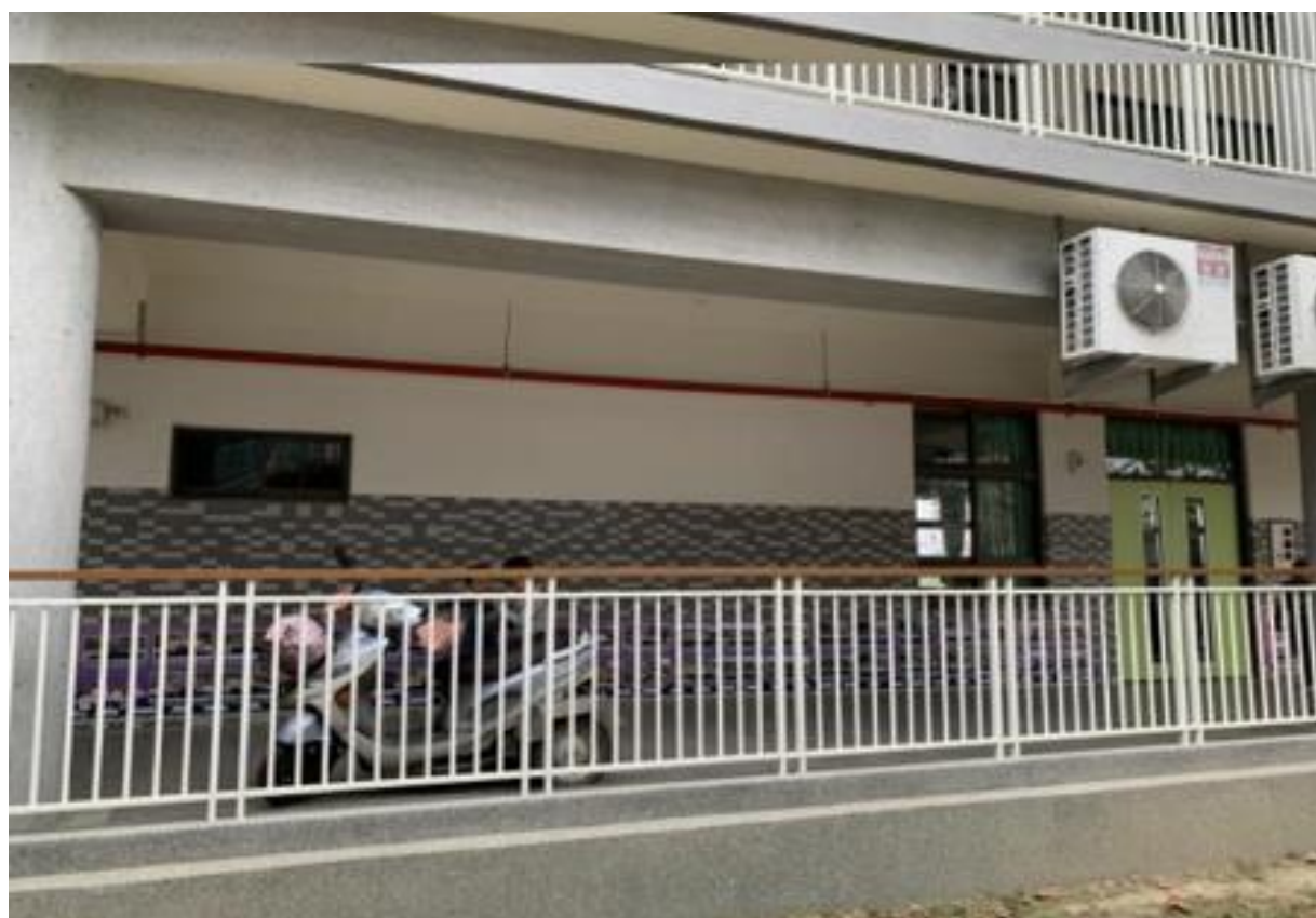
會議室(操場旁內側)
