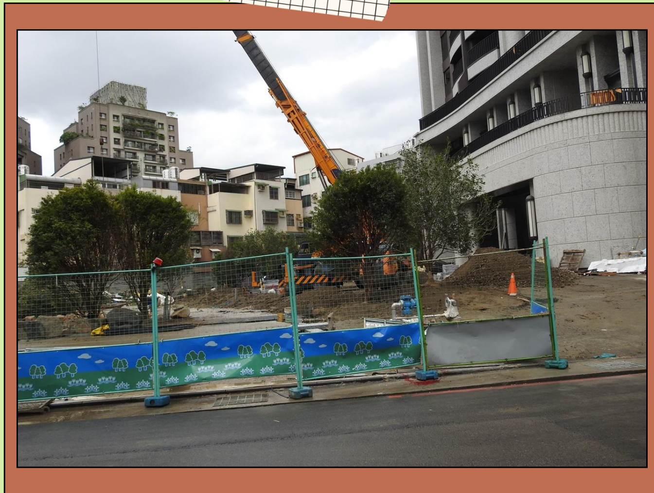
X巢對面的施工場地 X네스트 맞은편 공사현장
