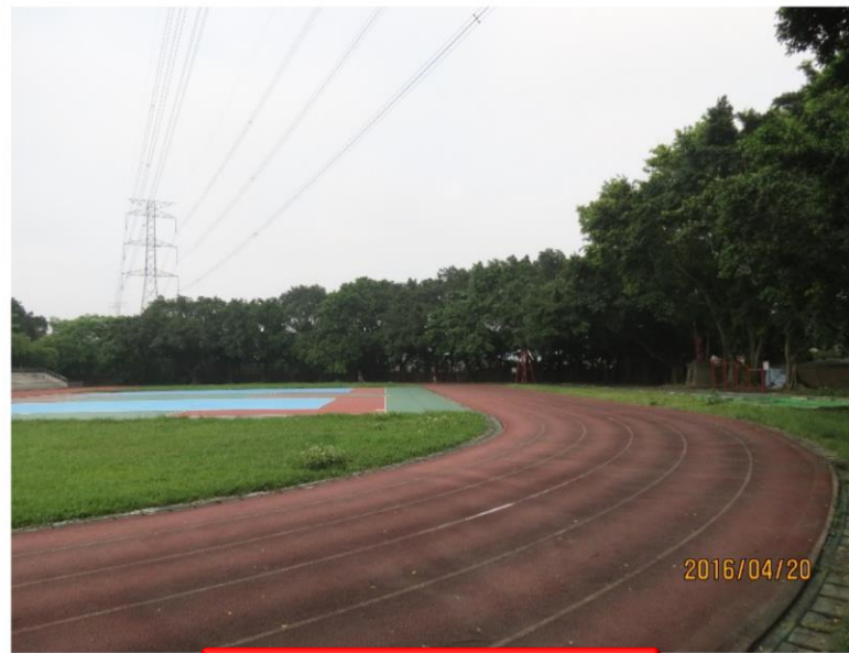
PU跑道面層磨損
