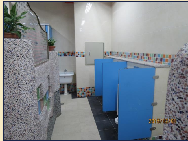
男廁所內小便器安裝完成
