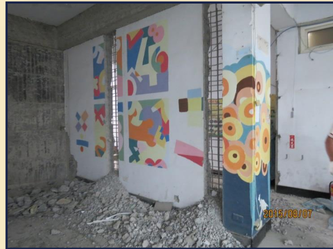
藝文中心牆面柱位增設剪力牆及擴柱
