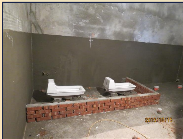
廁所內蹲式馬桶安裝
