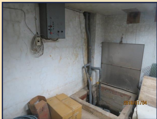
建德樓地下室箱涵儲水
