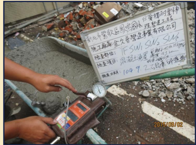
混凝土氯離子濃度測試
