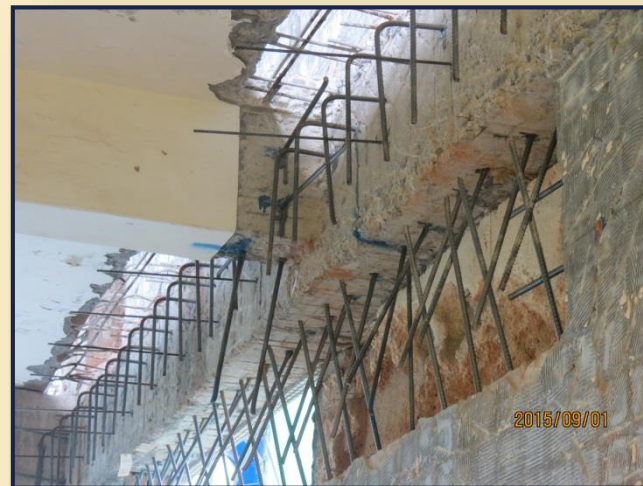
先進行結構補強作業
