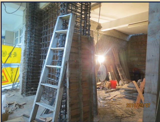
先進行結構補強作業
