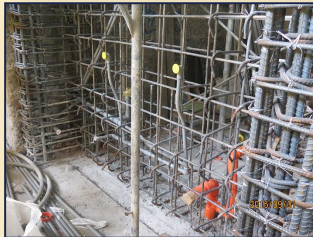
廁所入口側增設剪力牆
