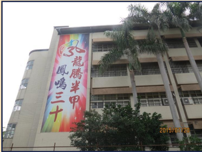
耐震補強工程前外觀
