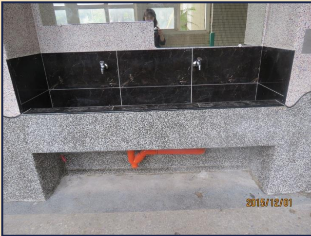
廁所外洗手台完成
