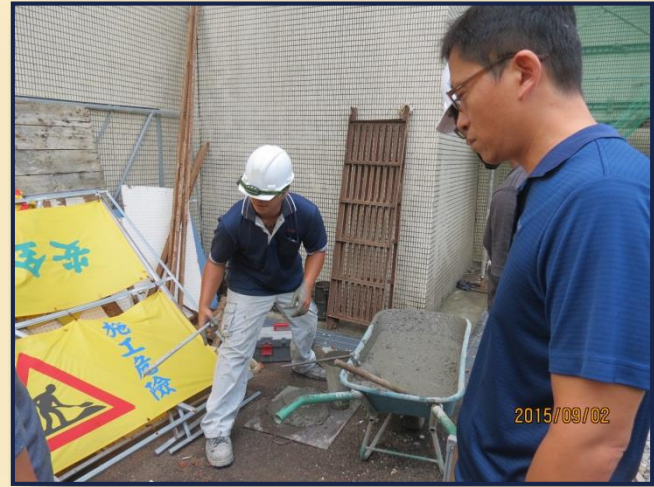
混凝土取樣測試
