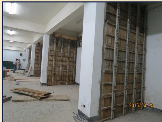
增設4處剪力牆加強耐震
