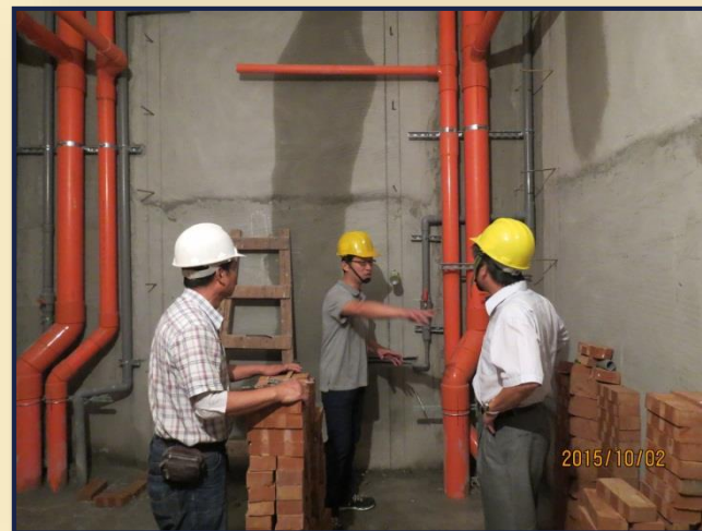
廁所內給排水管線施工中工程督導
