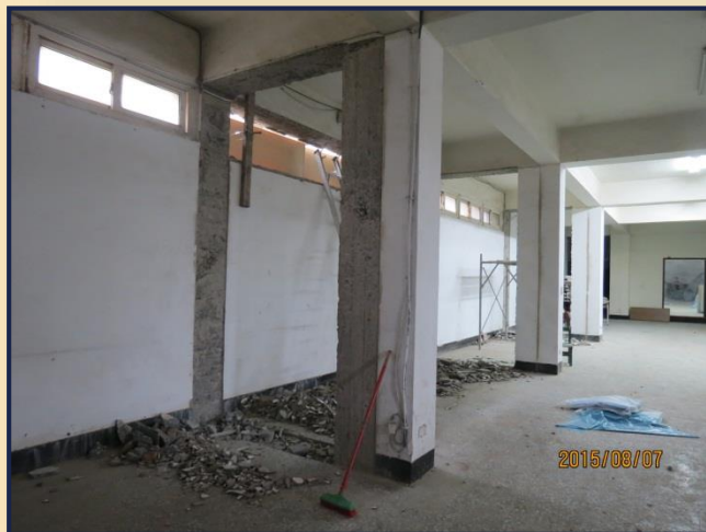
耐震補強工程前穿堂地下室外觀
