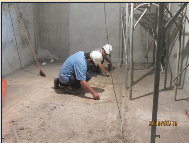
廁所內部整修施工前放樣
