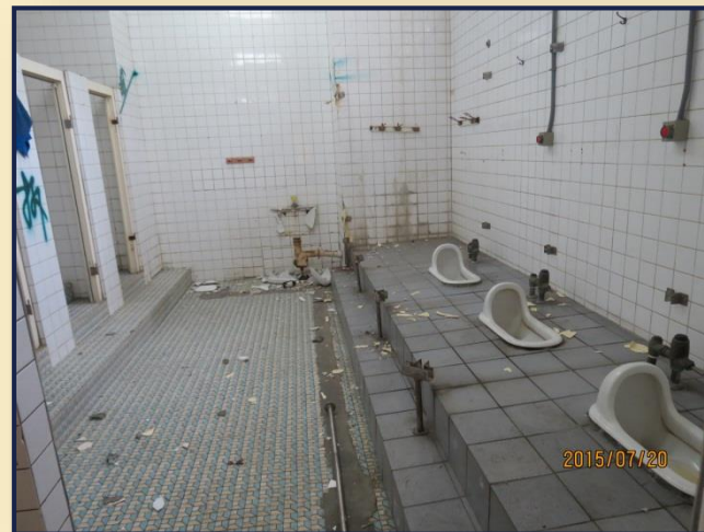
原有老舊廁所設施拆除
