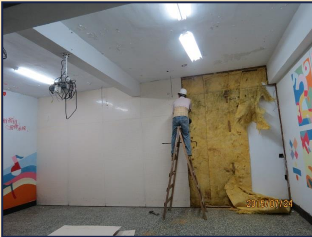
耐震補強工程前藝文中心外觀
