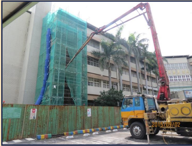
混凝土澆置現場情形
