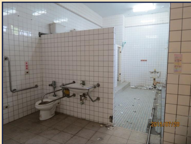
原有老舊廁所設施拆除
