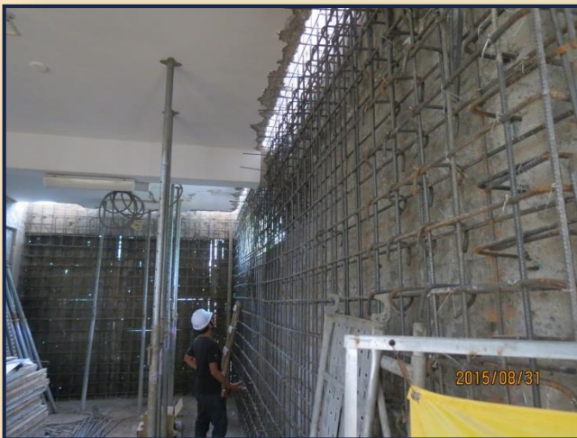
廁所內增設剪力牆
