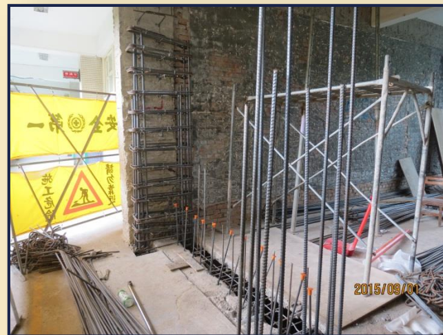
先進行結構補強作業
