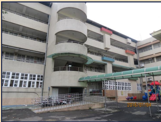
忠孝樓斜屋頂雨水回收
