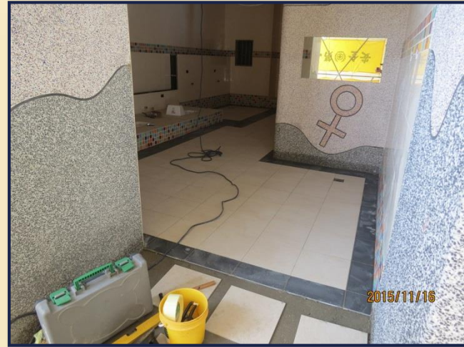
廁所地面磁磚安裝
