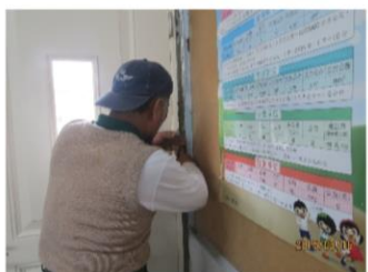
教室木門維修
