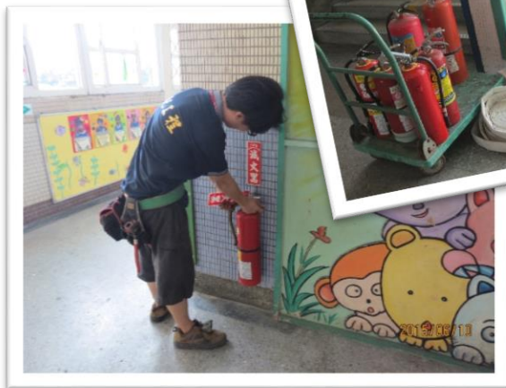
滅火器設置位置調整及補充
