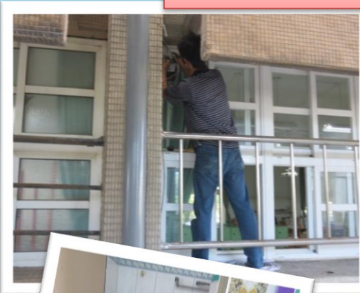
教室音箱維修
