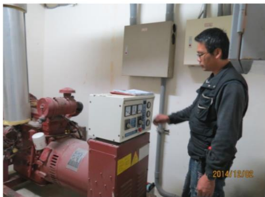
崇德樓發電機修復測試
