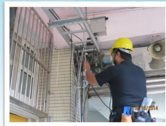
監視器線路查修
