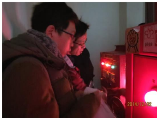
崇德樓消防泵浦測試
