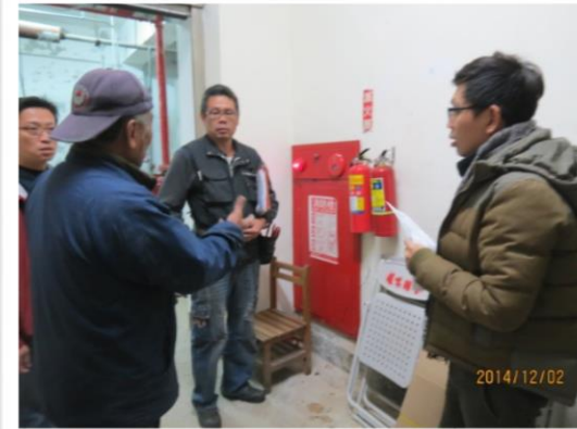
明德樓地下室消防測試
