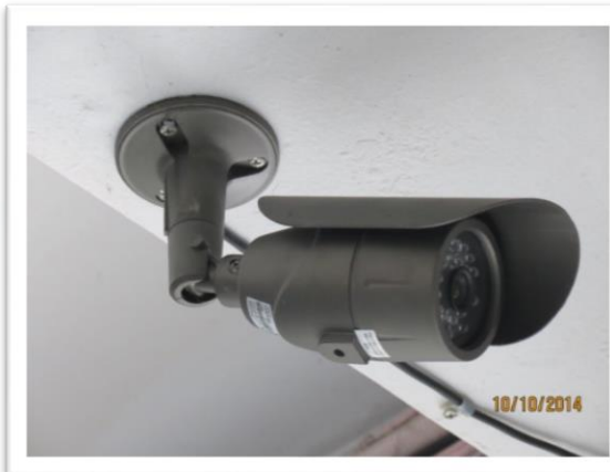
新設監視器鏡頭安裝
