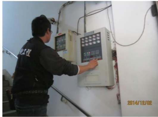
明德樓火災發報修復測試
