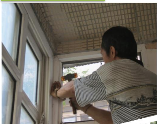
玻璃破損更換
