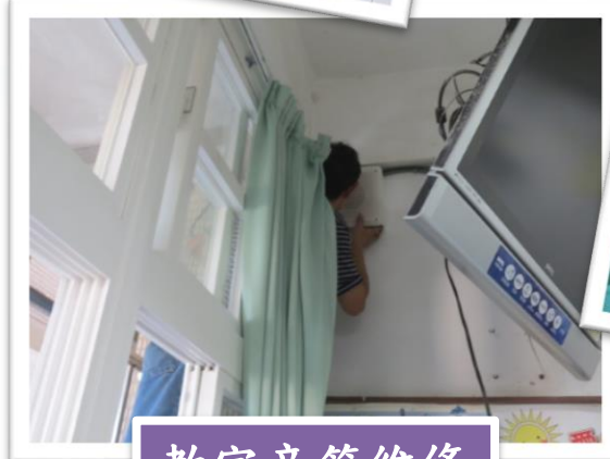
教室音箱維修
